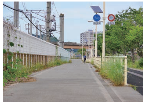
JR常磐線の脇に整備されたサイクリングルート
