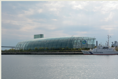
ドーム型のガラス屋根が特徴の施設外観
