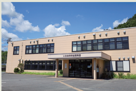
資料館のほか、遺物などを保管する収蔵庫も併設
