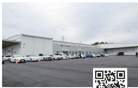
檜葉町に完成した新工場
