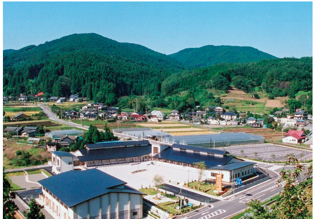
地区の「中核」となっている、田人ふれあい館。周辺には住宅、背後には山々が連なっている＝同右
